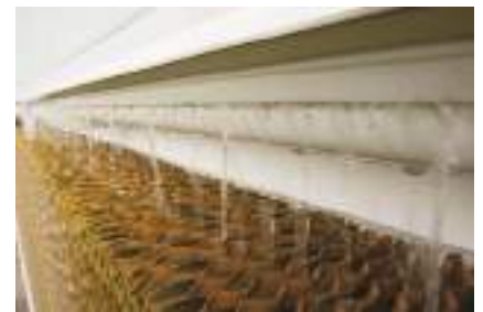
Le réflecteur d'eau spécialement conçu assure une répartition uniforme de l'eau sur le panneau de protection. Specially-designed water reflector ensures that water is equally distributed on pad panel.
