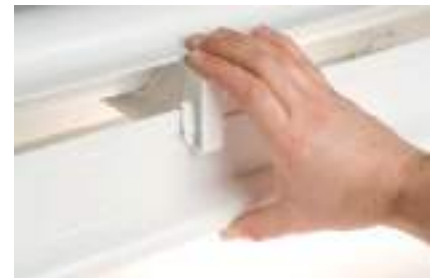
Un profil supplémentaire est utilisé afin de maintenir les peignes de refroidissement de manière régulière dans le panneau. Additional profile is used in order to keep cooling combs in a regular form in the panel.
